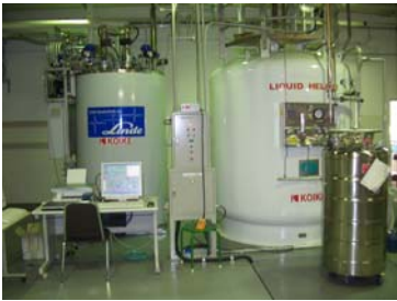
L140 液化機と 4000L 液化ヘリウム貯槽
