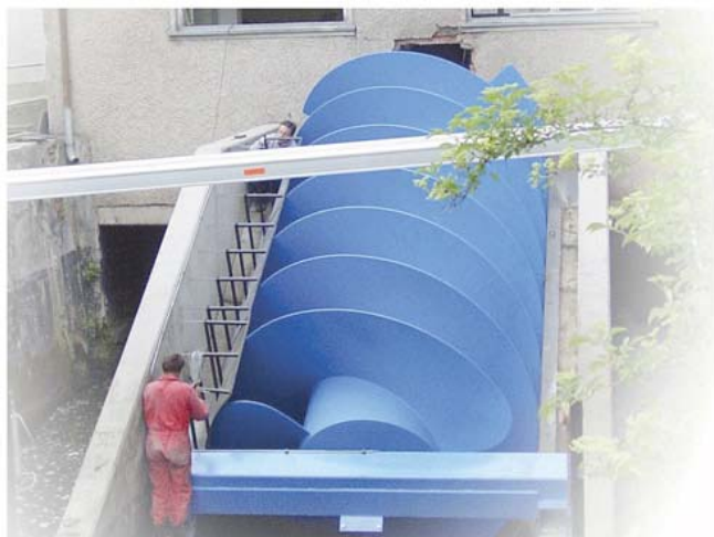
写真2 ドイツのらせん水車 (Ritz-Atro GmbH 社製, 出力: 45kW 流量: 2,800l/sec, 落差: 2.38m)
