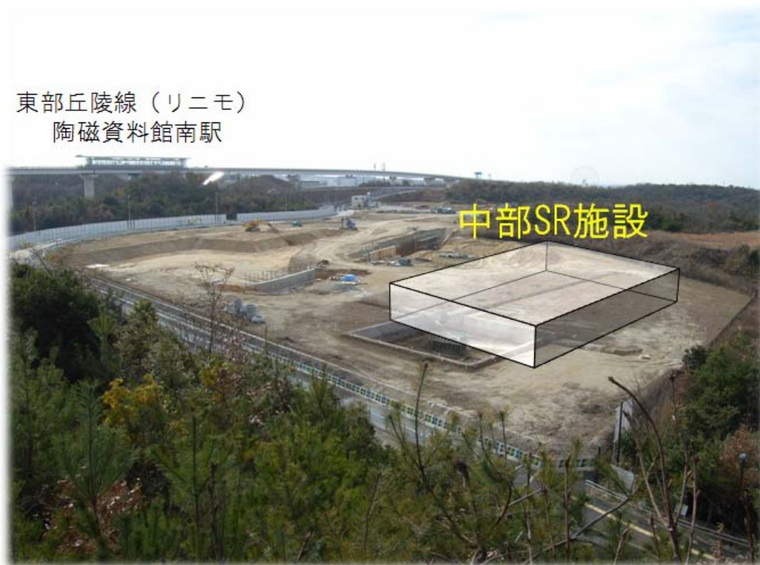
図 10 造成工事状況（平成 21 年 12 月 27 日）
