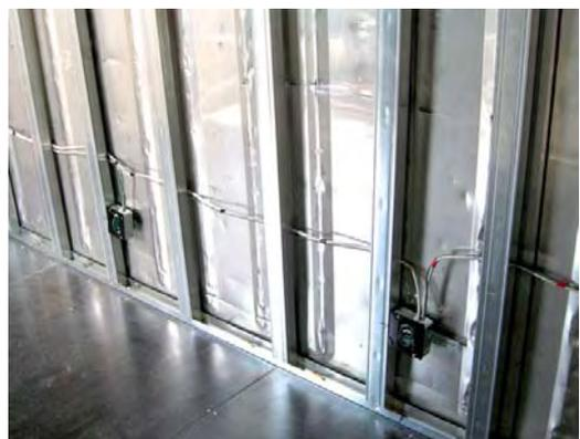
図 7 施工中のコンテナ内の壁合板を張る前で軽天と電源配線が見える
