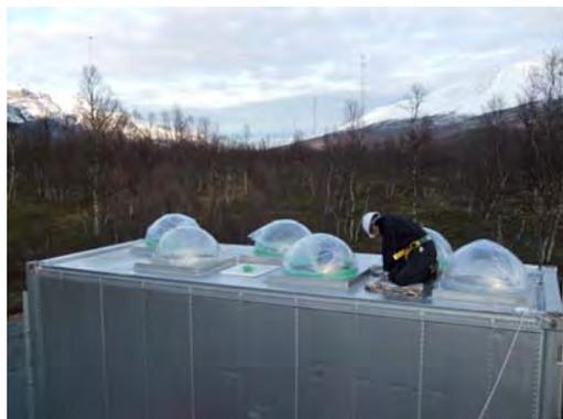
図 22 送信コンテナに取り付けられたドーム天窓
