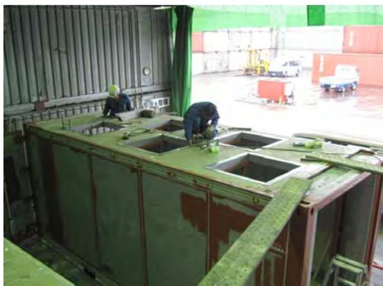
図12 施工中の受信コンテナの屋根
