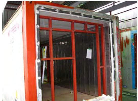
図 5 冷凍ユニットを取り外した部分で作られている壁と入口の骨組
