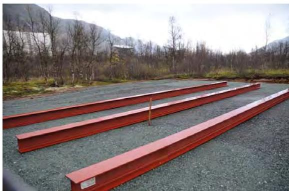
図 20 コンテナの土台として用意された H 鋼
