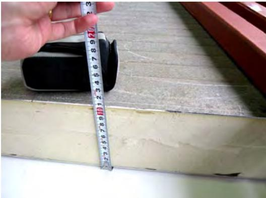
図 4 冷凍コンテナの断熱壁 上面が外側
