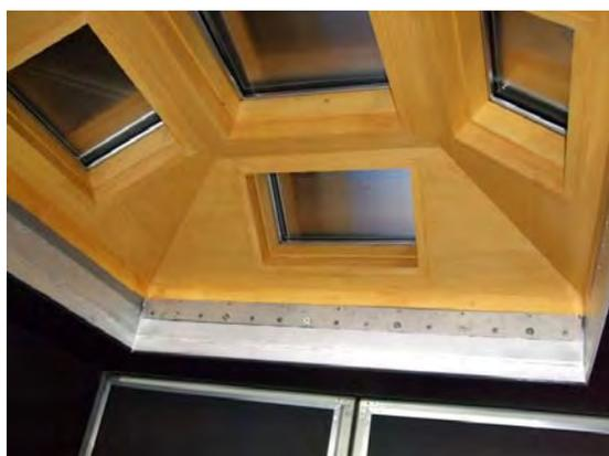
図 10 レーザー用天窓（室内側）
