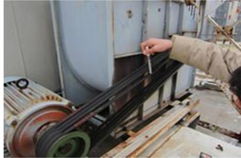
図.7 Vベルトの検査
