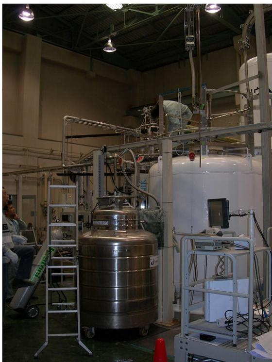
図 1.500L バッセルから He 貯槽へ逆トランスファーして貯槽を冷やす作業
