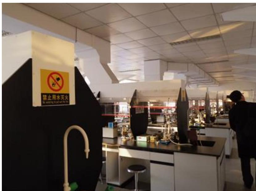
図 5. 全ての学生用実験台に設置された局所排気装置
